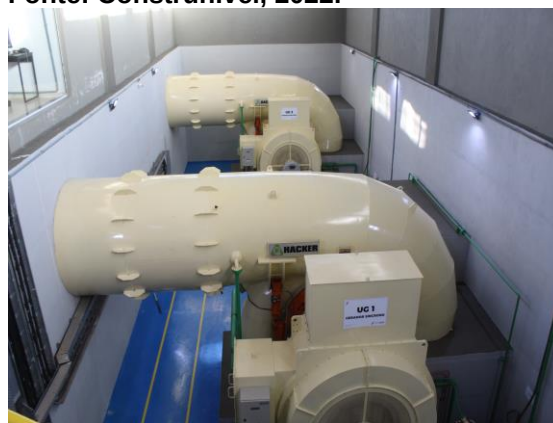
Figura 3.4: Turbinas Kaplan. Fonte: Construnível, 2022
