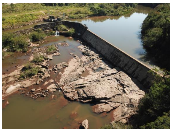
Figura 3.1: Barramento em contrafortes. Fonte: Construnível, 2022.
