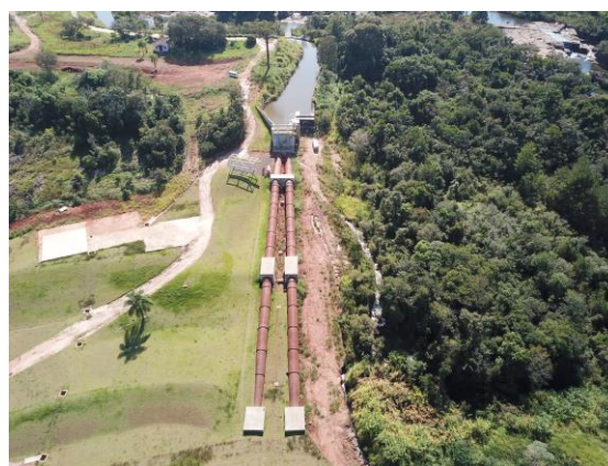
Figura 3.2: Canal adutor e conduto forçado. Fonte: Construnível, 2022.
