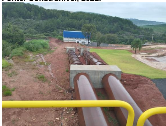
Figura 3.3: Canal adutor e casa de força. Fonte: Construnível, 2022
