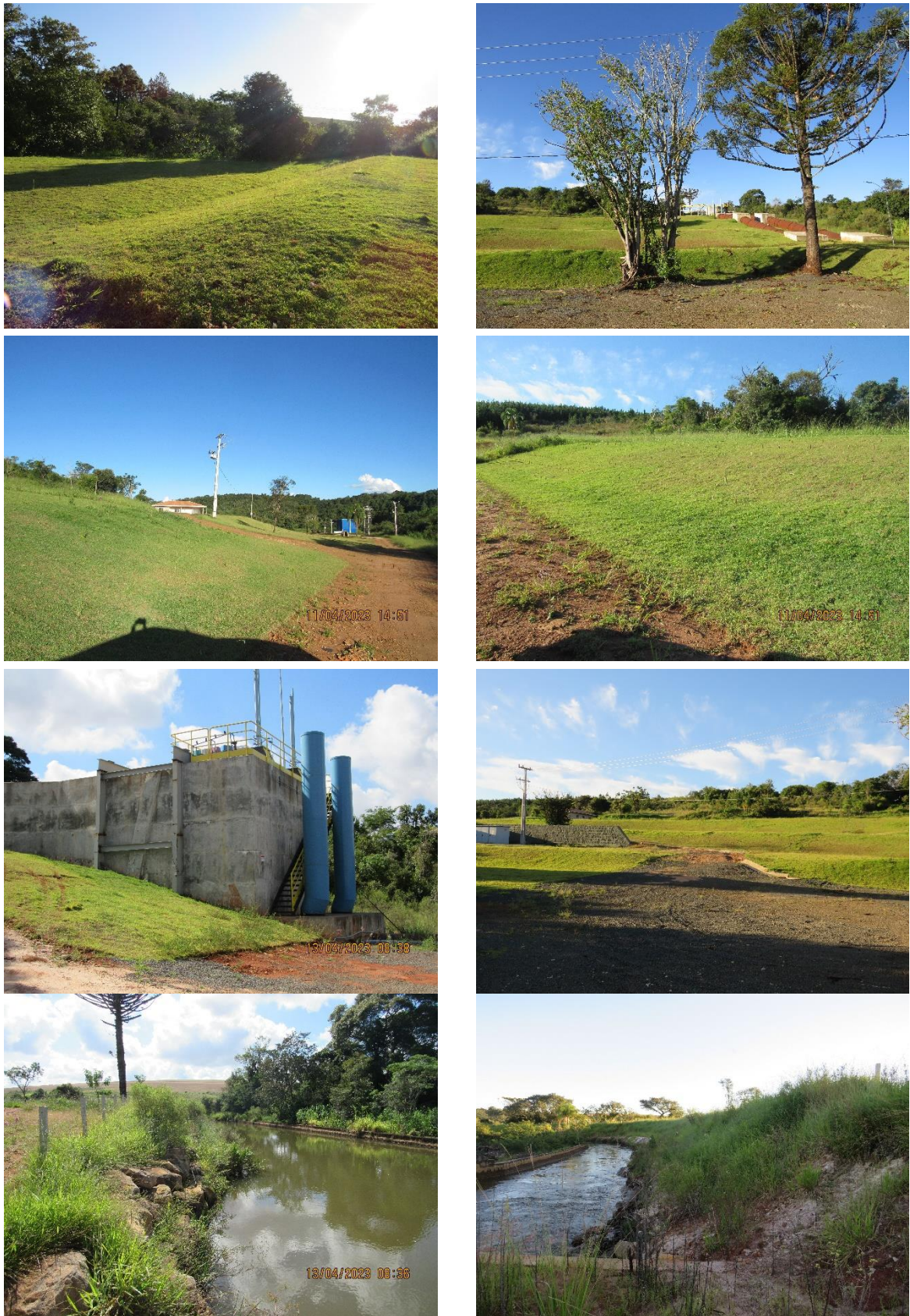
Figura 6.1: Taludes ao longo da obra da CGH Rincão da Ponte. Fonte: Construnível, 2023.
