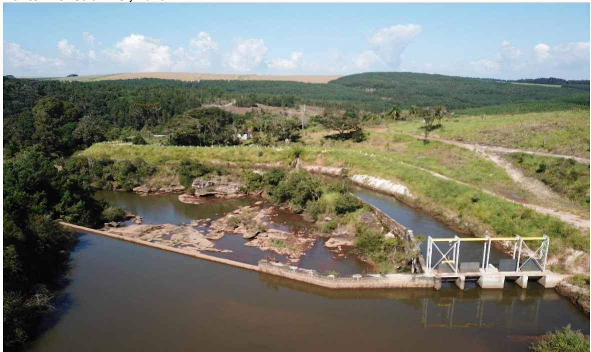
Figura 6.3: Vista aérea dos taludes ao longo do canal adutor. Fonte: Construnível, 2023.
