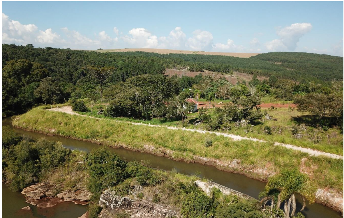
Figura 6.2: Vista aérea dos taludes ao longo do canal adutor. Fonte: Construnível, 2023.
