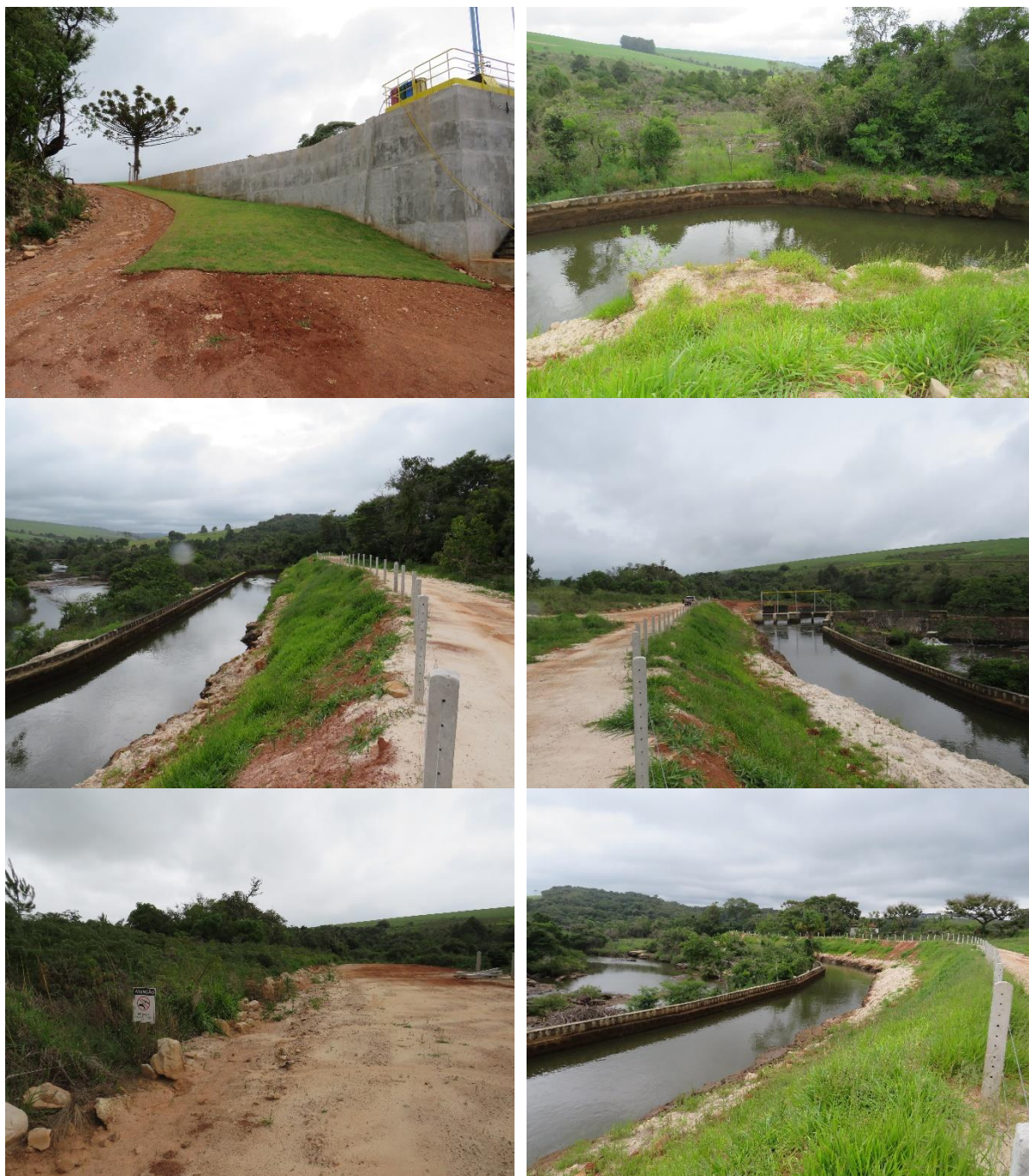
Figura 11.1: Áreas recuperadas da CGH Rincão da Ponte. Fonte: Construnível, 2021.
