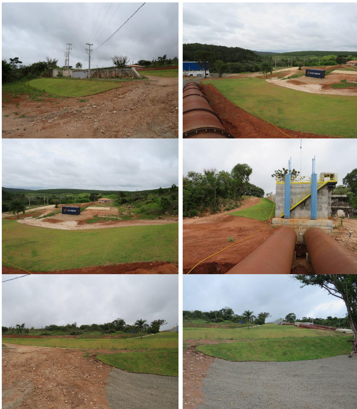
Figura 10.1: Taludes ao longo da obra da CGH Rincão da Ponte. Fonte: Construnível, 2021.
