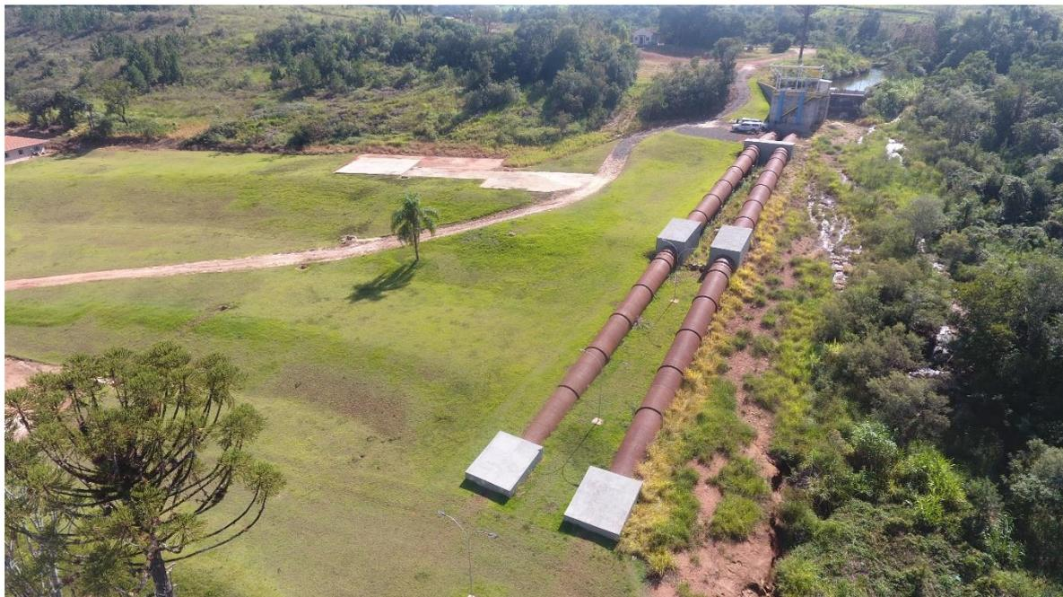
**Figura 3.5: Visão aérea da câmara de carga e condutos forçado.**
